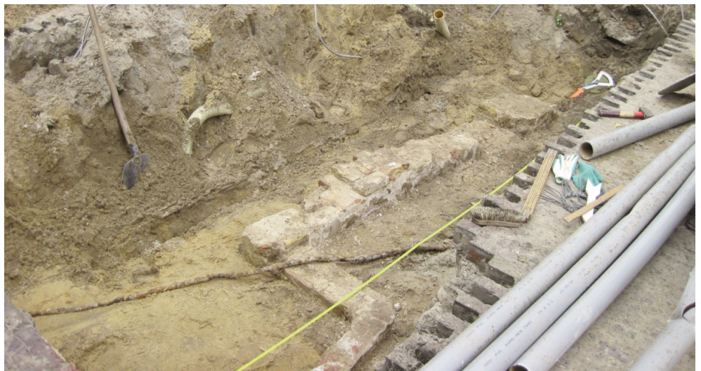
afbeelding x, Afb. AND'12 Overzichtsfoto, met op de voorgrond de kelder muur
